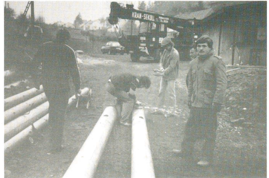
Aufstellen der Flutlichtmasten
